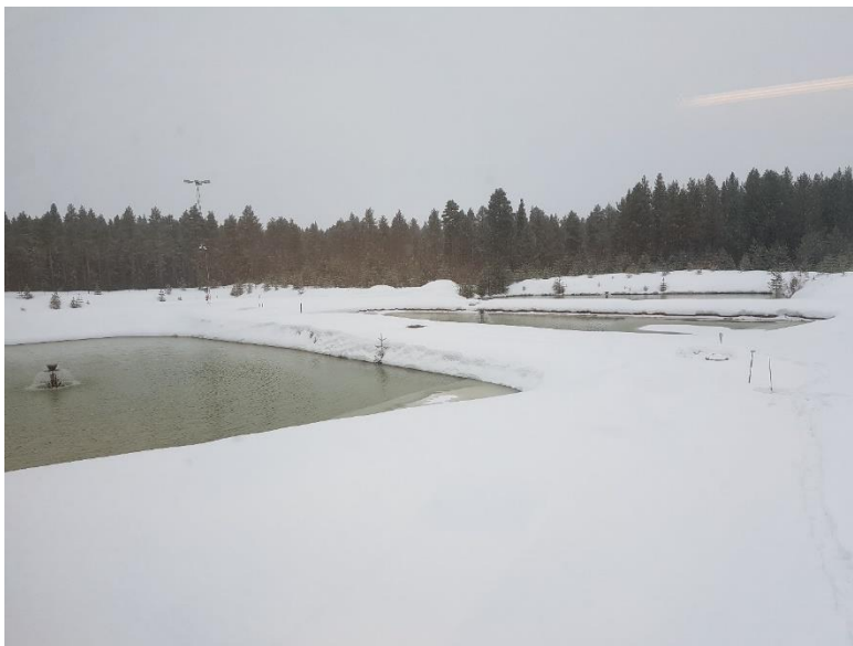
Figur 6: Tre av infiltrationsbassängerna på Kusön.
