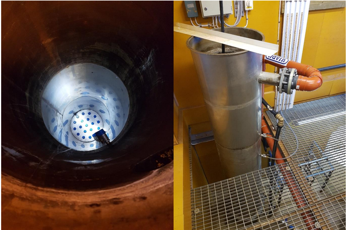
Figur 8: Insidan av pilotfiltret med dysor (blå cirklar i botten) och intag för de fem kranarna där trycket mäts till vänster och helhetsbild av pilotfiltret till höger.
